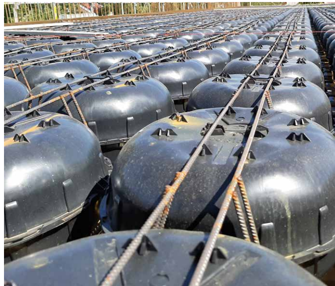
Bild 4 Durch die Verwendung von 34.398 Cobiax-Hohlkörpern konnten beim Ersatzneubau der Hochschule Ulm 1.210 Tonnen Beton eingespart werden.
