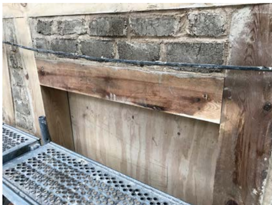
Wiederherstellung einer Außenwand aus mit Lehmziegeln ausgefachtem Fachwerk.
