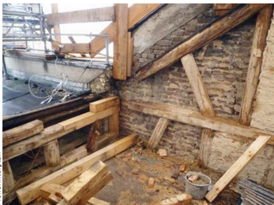
Sanierung der Schädigung durch einen Bauholzpilz im Dachstuhl.
