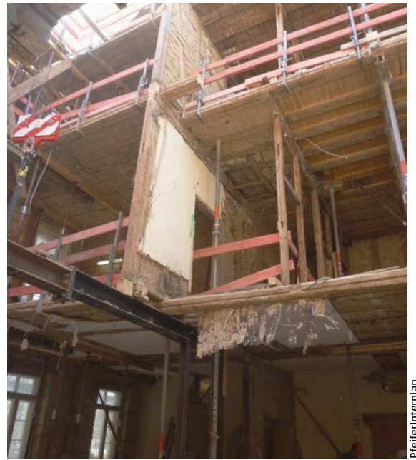
Bauzustand während der Rohbauphase.
