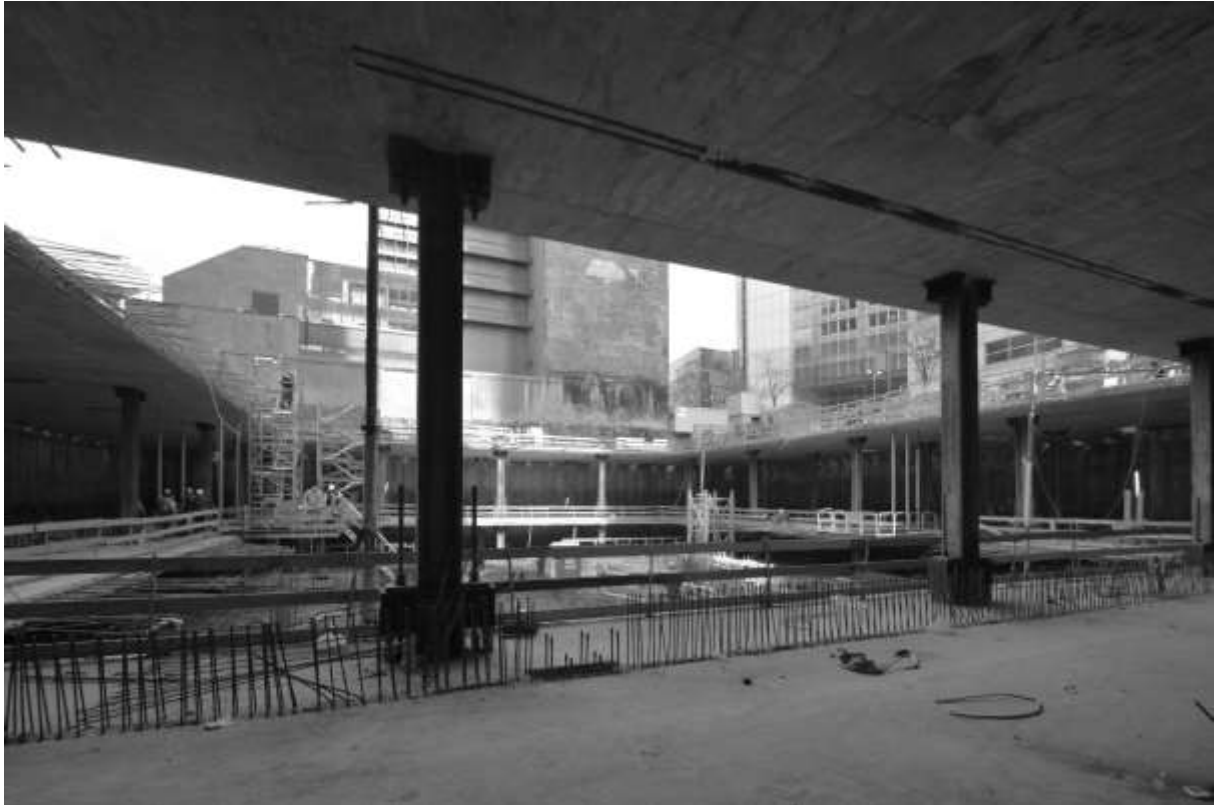
Abb. 3 Baugrube mit Bohrfahlewand ohne Rückverankerung mit Teildeckeln und temporären Stützen (Foto PfeiferINTERPLAN)
