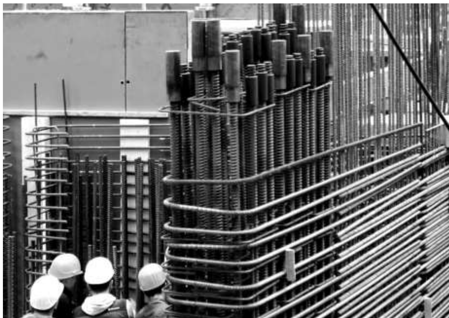
Abb.17: Bewehrungsdichte an den Enden der Kernwände mit SAS 670 d=43 mm (Foto: PfeiferINTERPLAN))
