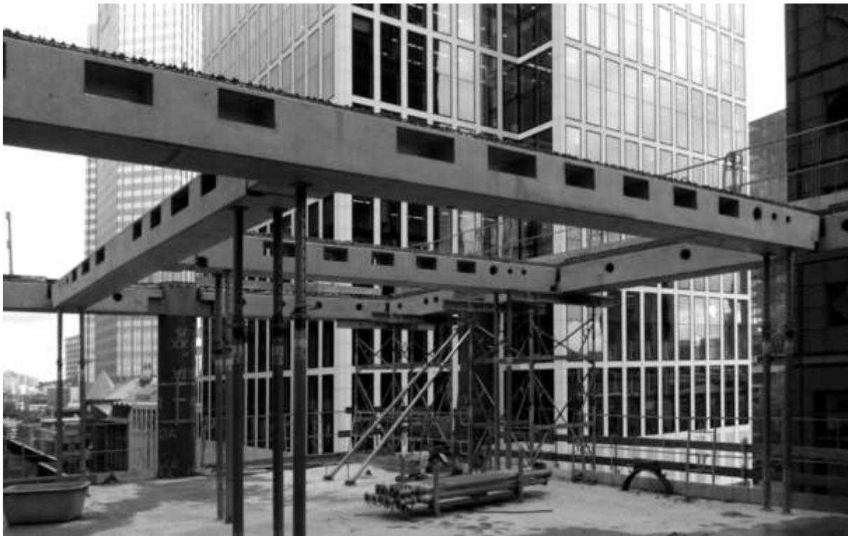
Abb.19: Fertigteilkonstruktion im LR- und HR-Bereich (Foto: PfeiferINTERPLAN)
