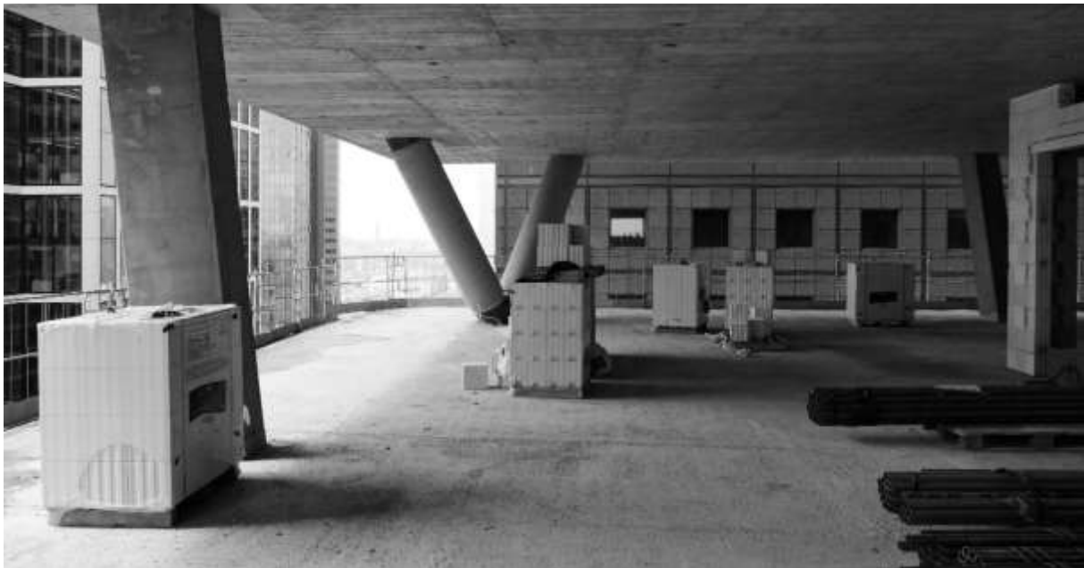
Abb. 11: Eckstützen im 15. OG und Stahleinbauteil in der Decke zur Aufnahme der Umlenkraft (Fotos: Pfeifer-INTERPLAN)
