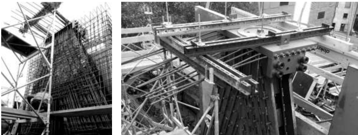
Abb.13: Montage des A-Bocks, Lasteinleitungsstruktur mit „Quetschplatte“ (Fotos PfeiferINTERPLAN)
