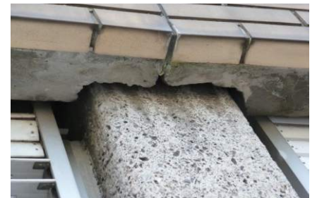
Übergang zweier Brüstungs-Fertigteilelemente der Fassade über einer Stahlbetonstütze
