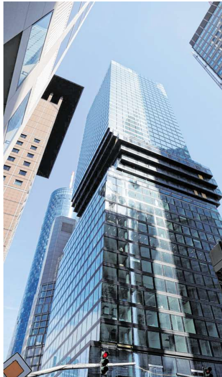
Der Omniturm in Frankfurt vereint Büro-, Wohn- und öffentliche Räume. Damit ist das Bauwerk das erste Hochhaus Deutschlands mit gemischter Nutzung. BILD: PFEIFER
