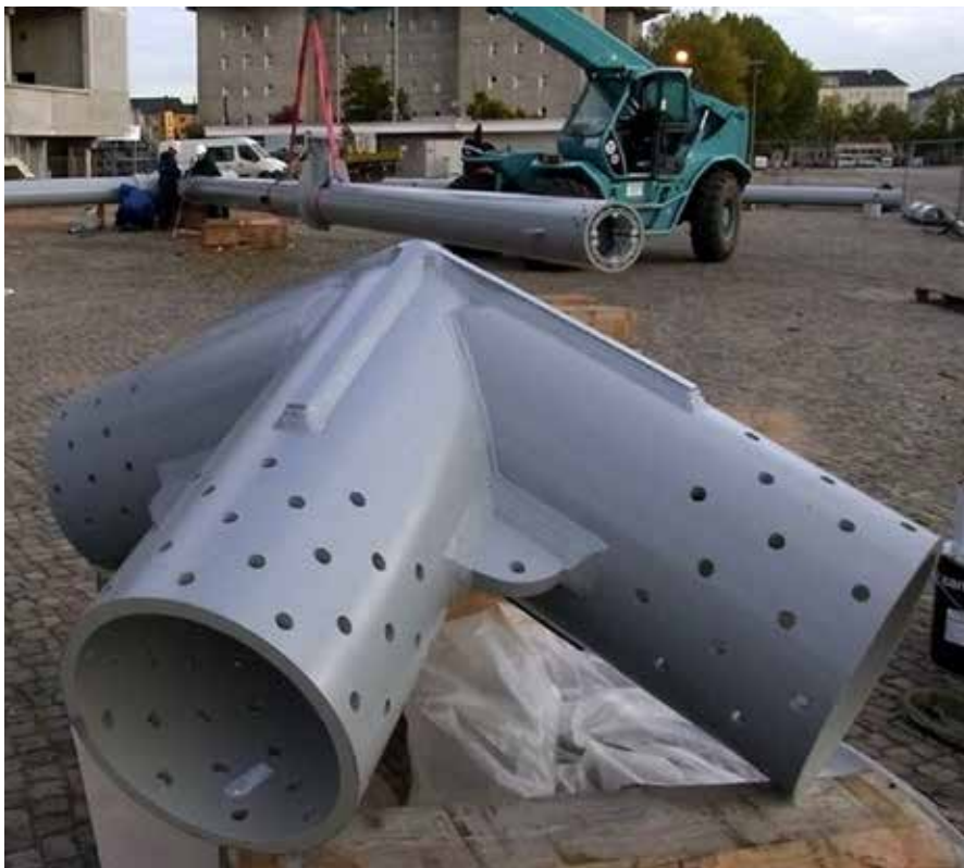
Bild 8: Zentraler Knoten im Obergurt in der Ausführung
