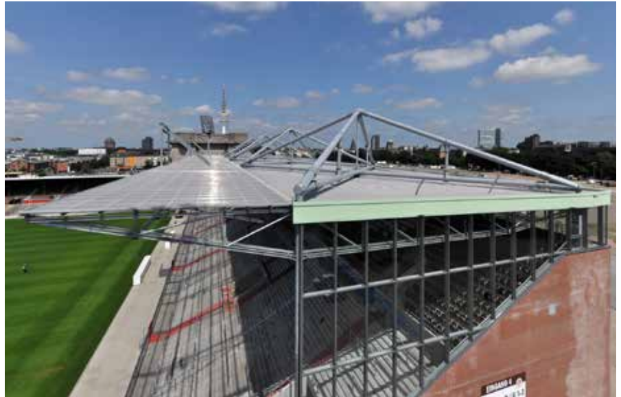
Bild 5: Stab-Pyramiden oberhalb des Daches als Hauptkonstruktion
