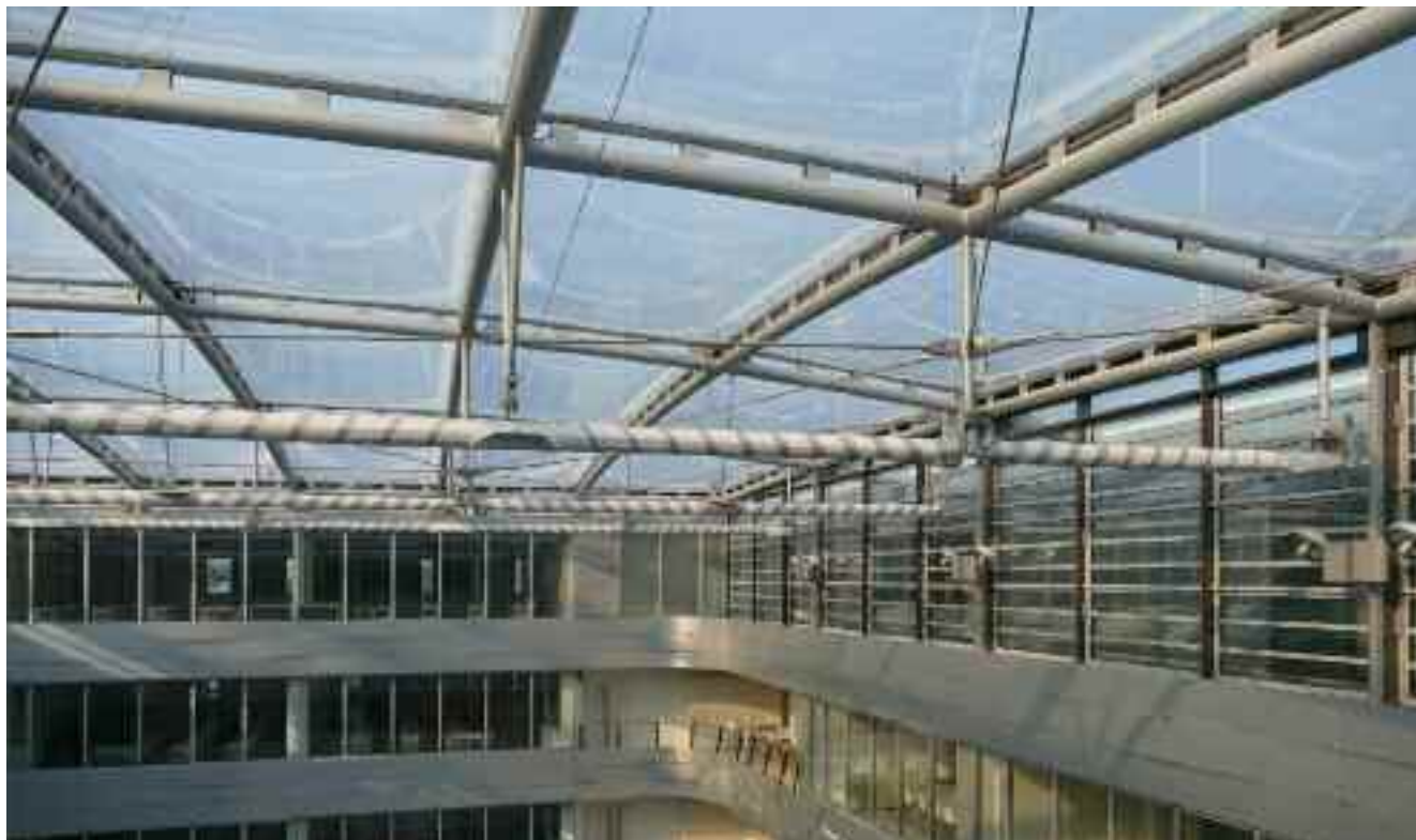
▲ Unterspannte Dachkonstruktion mit eingerollten, dreieckigen Sonnenschutz-Segeln
