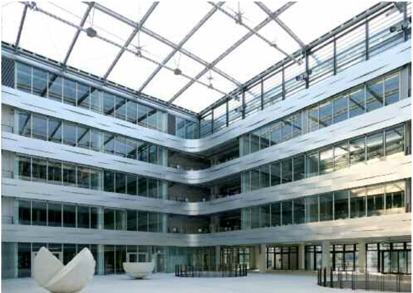
▲ Lichtdurchflutetes Atrium kurz vor der Fertigstellung
