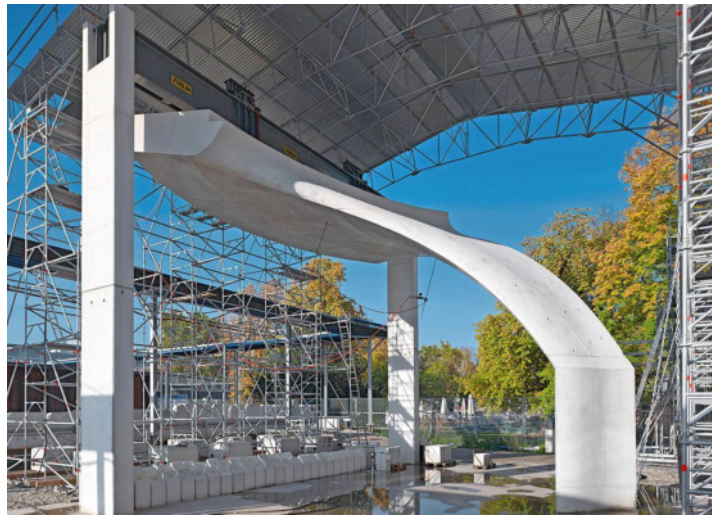
Ein Kelchmuster in Weißbeton wurde vor Ort in Stuttgart von den Tragwerksplanern hergestellt. FOTO: ZIBU
