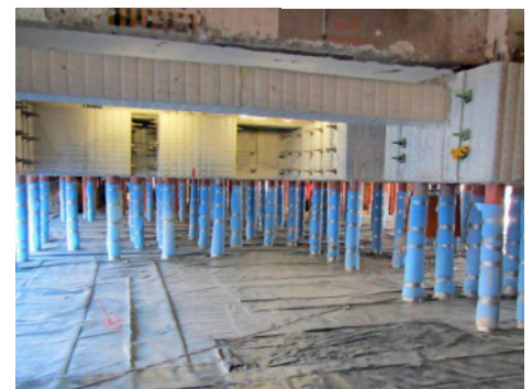
Kellergeschoss der ehemaligen DB-Direktion in der Nähe des Hauptbahnhofs Stuttgart. Rund 500 Kleinbohrpfähle stützen die Fundamente des denkmalgeschützten Baus.
