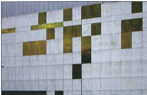
**Bilder 14 und 15:** Marmorfassade nach der Sanierung mit Messingplatten
